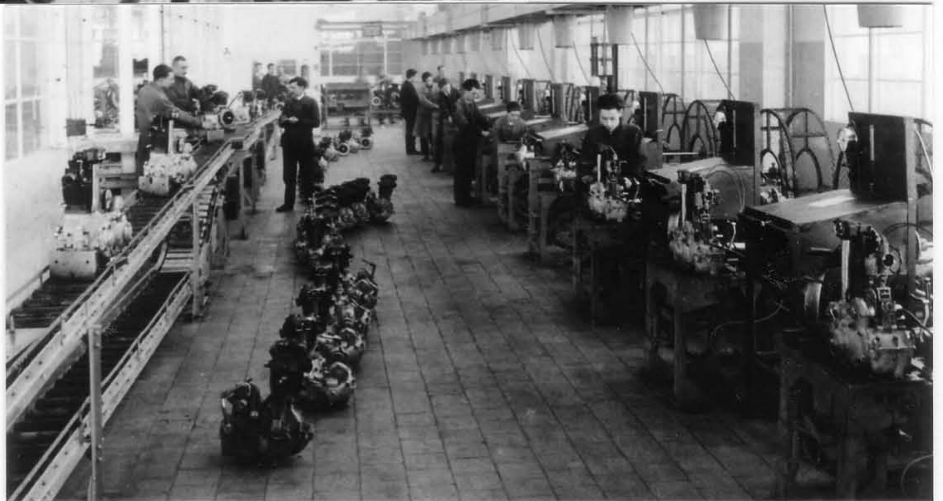
Banc d'essais pour moteurs. Vue des moulinets et du dispositif de mise en marche des moteurs.
