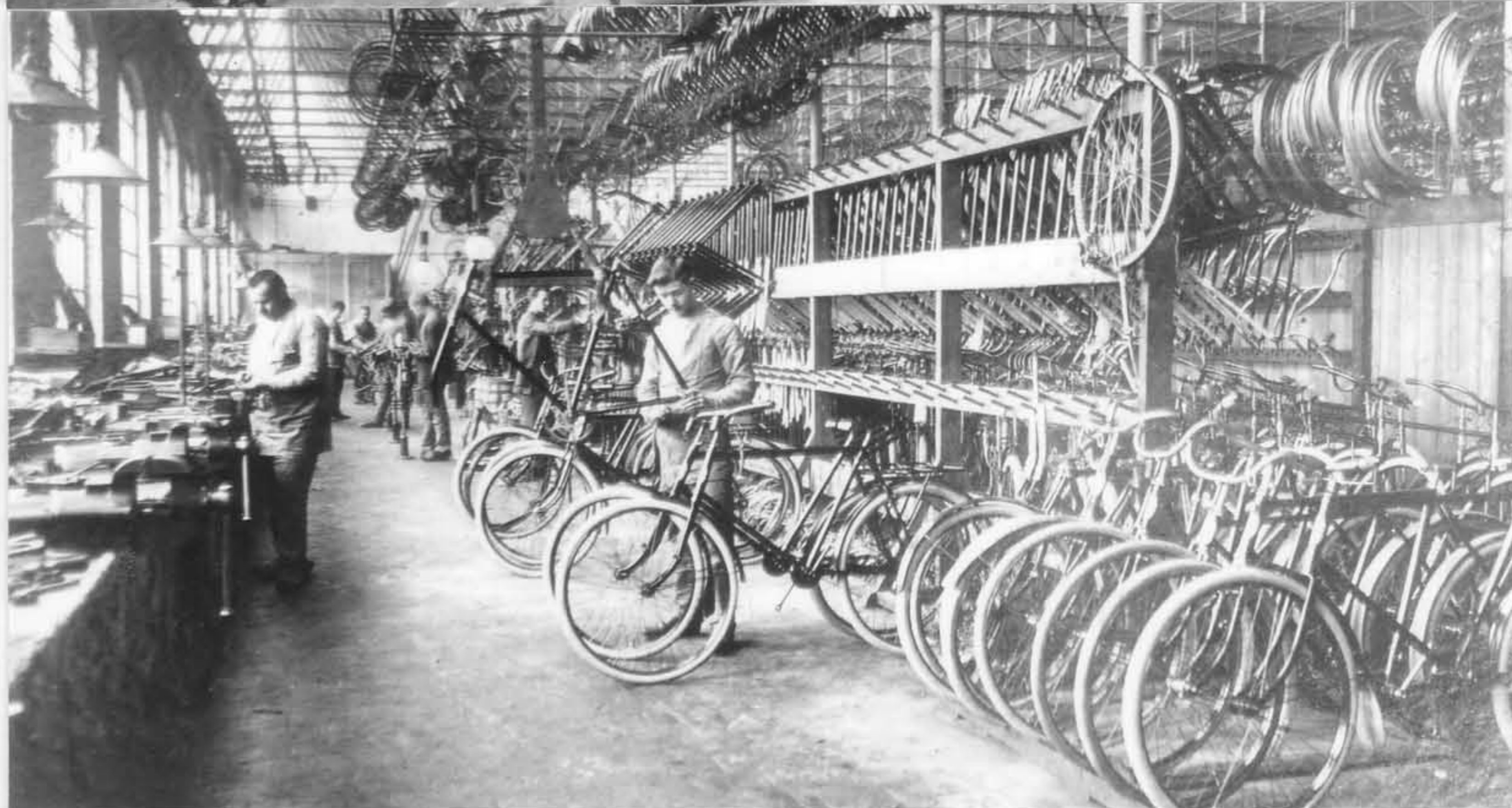
Hall de montage des vélos.
