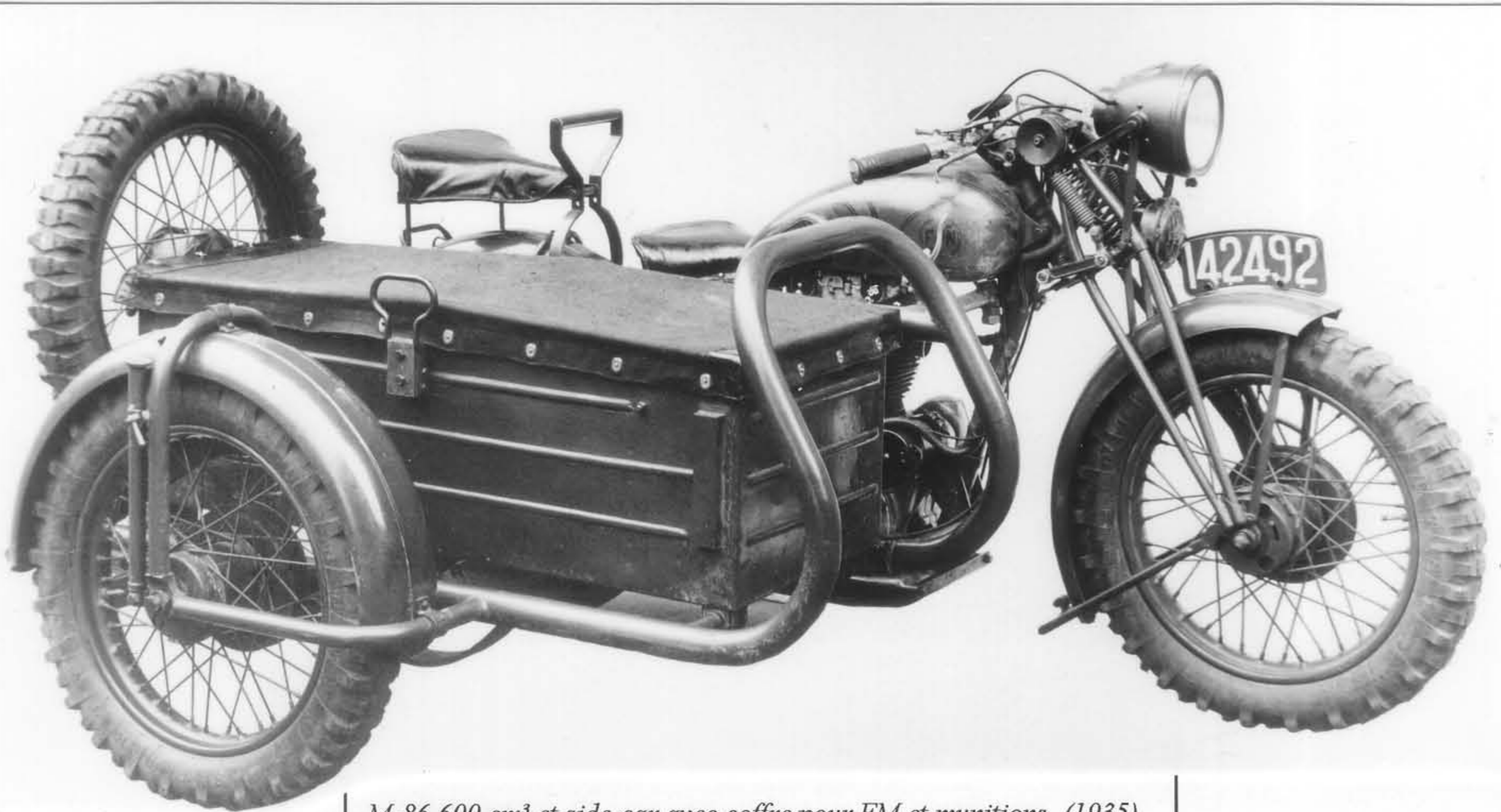
M-86 600 cm 3 et side-car avec coffre pour FM et munitions. (1935)
