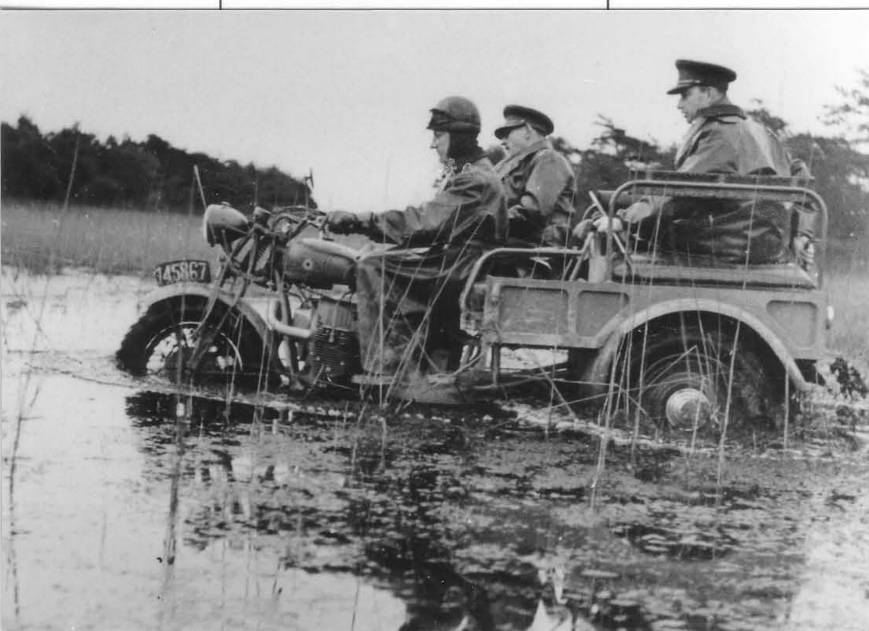
Test du tricar sous les yeux d'officiers belges. Ce T-3 est un prototype. Pour exemple il a encore une fourche avant de M-12.
